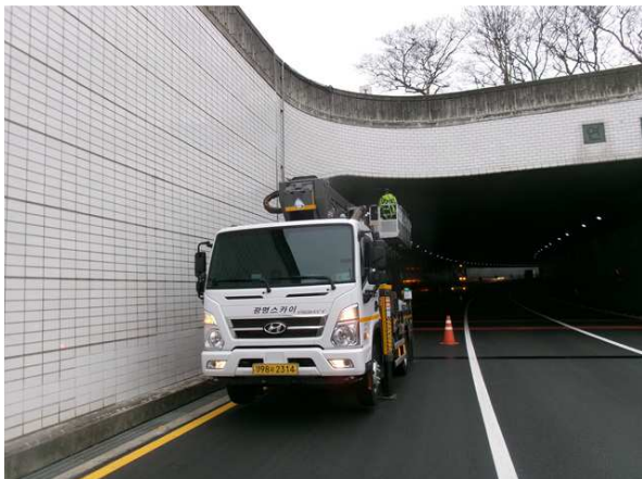
고소점검차를 이용한 근접조사
